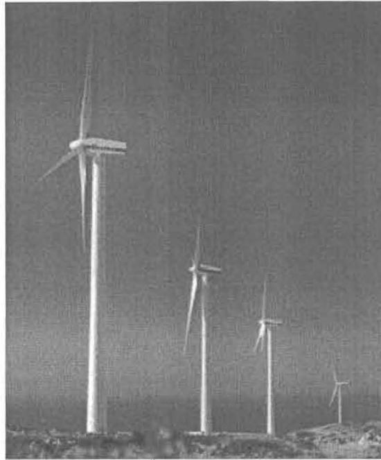
Figure 4.23 Vestas V52 850-kW wind turbine (Vestas).
